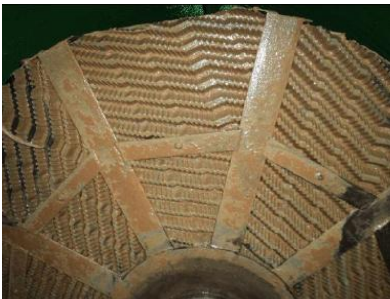
Slika 3.5. Polipropilenske saće s kolonijama bakterija
