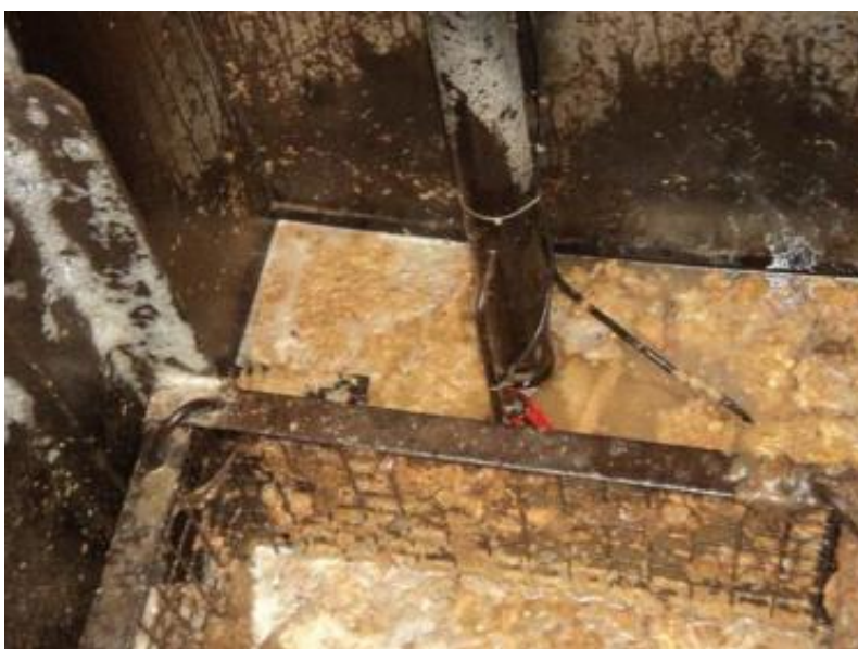
Slika 3.4. Prihvatna komora sa zaštitnom mrežicom
